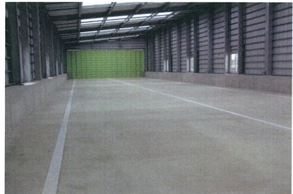
堆肥発酵舎内部
